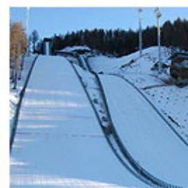
La scelta di utilizzare impalcati prefabbricati sia per le piste di lancio (con struttura di acciaio) che per quelle di atterraggio (con struttura di cemento armato), oltre a rendere possibile la regolazione delle piste, ha inoltre reso più efficiente la complessa fase di realizzazione dei manufatti su versante scosceso e in condizioni ambientali di montagna.
